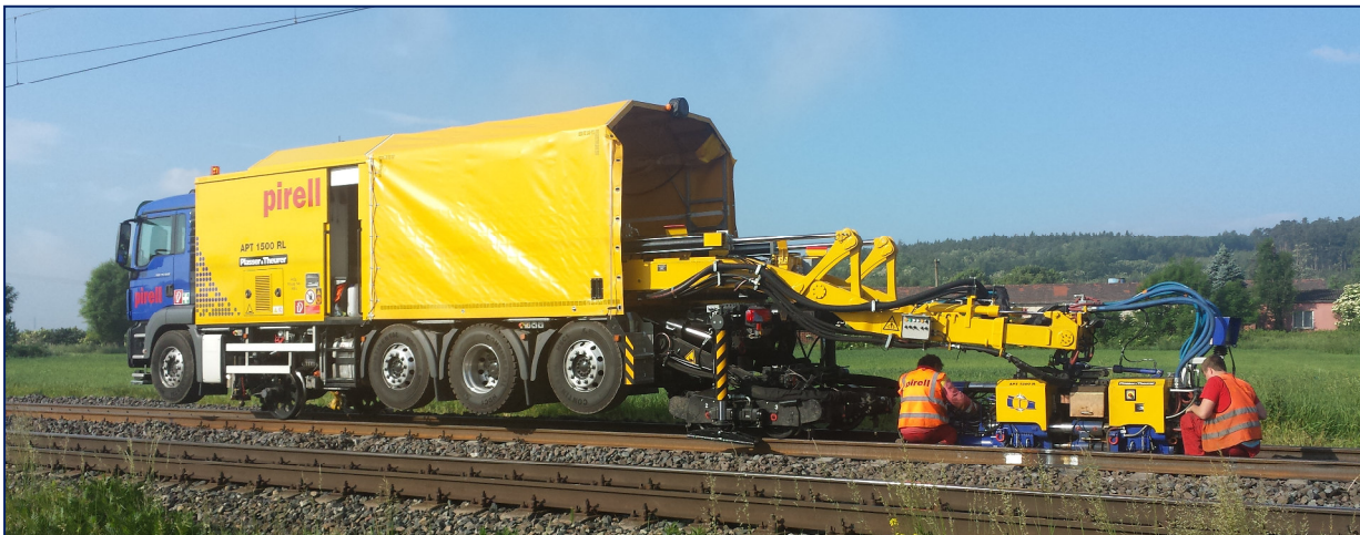
Celkový pohled na svařovnu, 2. 6. 2015
