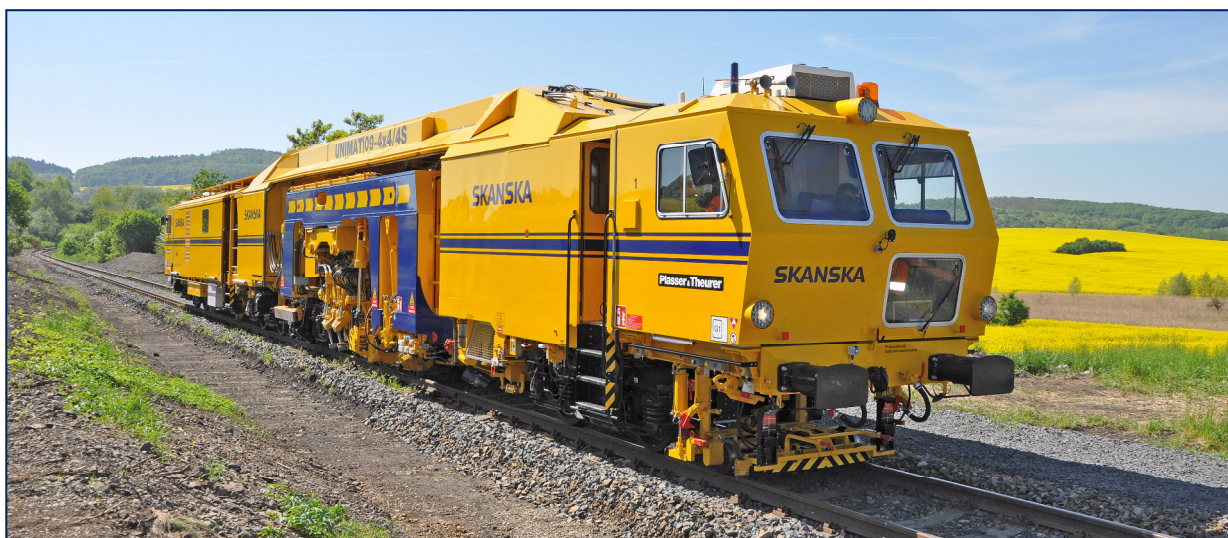
Stroj při uvádění do provozu a zaškolování obsluhy na trati Čížkovice - Obrnice, 18. 5. 2017
