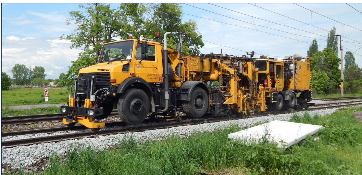
Stroj při propracování koleje v úseku Čelákovice – Lysá nad Labem, 15. 5. 2017
