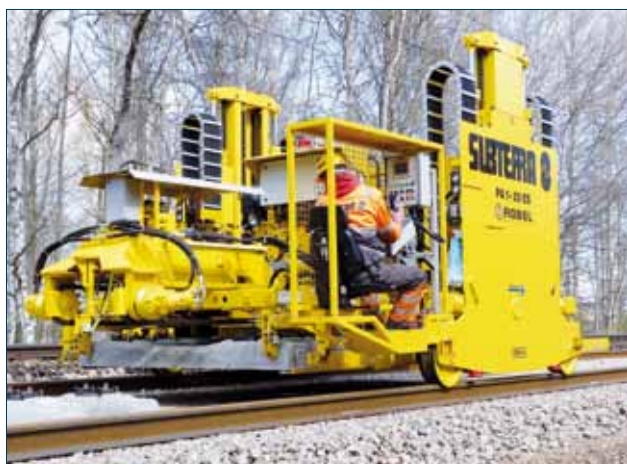
Přeprava pražců na místo pokládky
