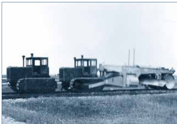
Celkový pohled na bezkolejovou čističku
