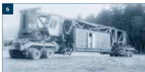
7. Parní jeřáby Škoda 20 t a 25 t při manipulaci s mostem jeřábu UK 25/9
