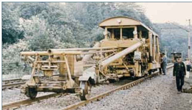
Podbýječka při úpravě traťové koleje
