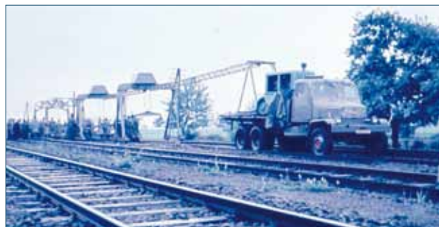
Funkční vzor kladecí sestavy dvou jeřábů Husák tažené automobilem P V3S
