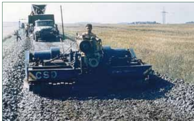
Zhutňovač UM s dodatečně osazeným spalovacím motorem.
